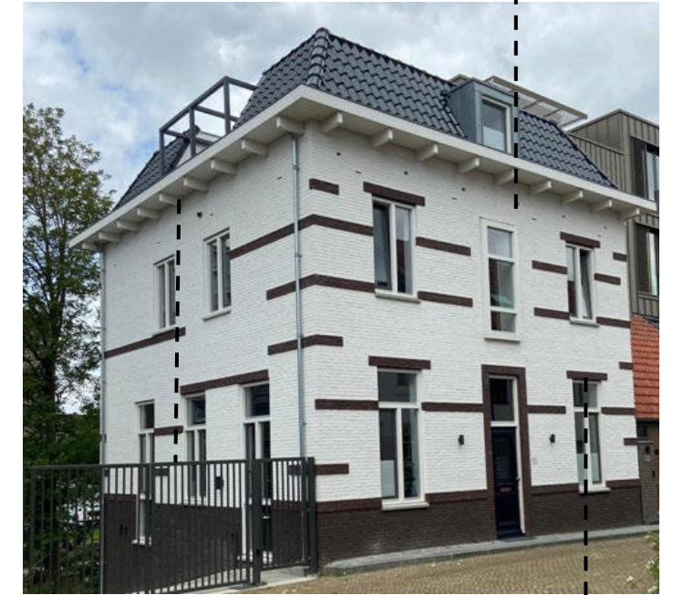
metselwerk (rollaag) boven kozijnen
