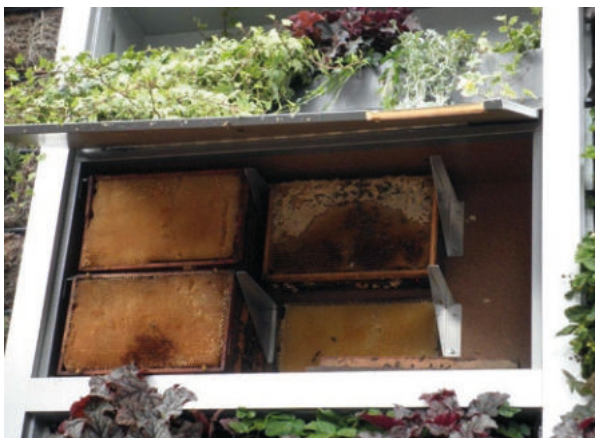
bijkasten verwerkt in gevel
