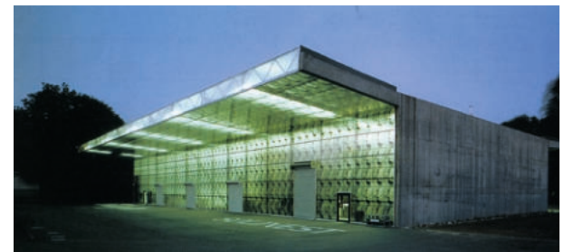
referentiebeeld verlichting totale gebouw
