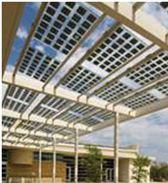
zonnecellen verwerkt in dak
