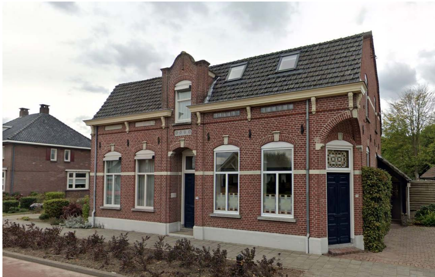
lintbebouwing villa met rijke detaillering
