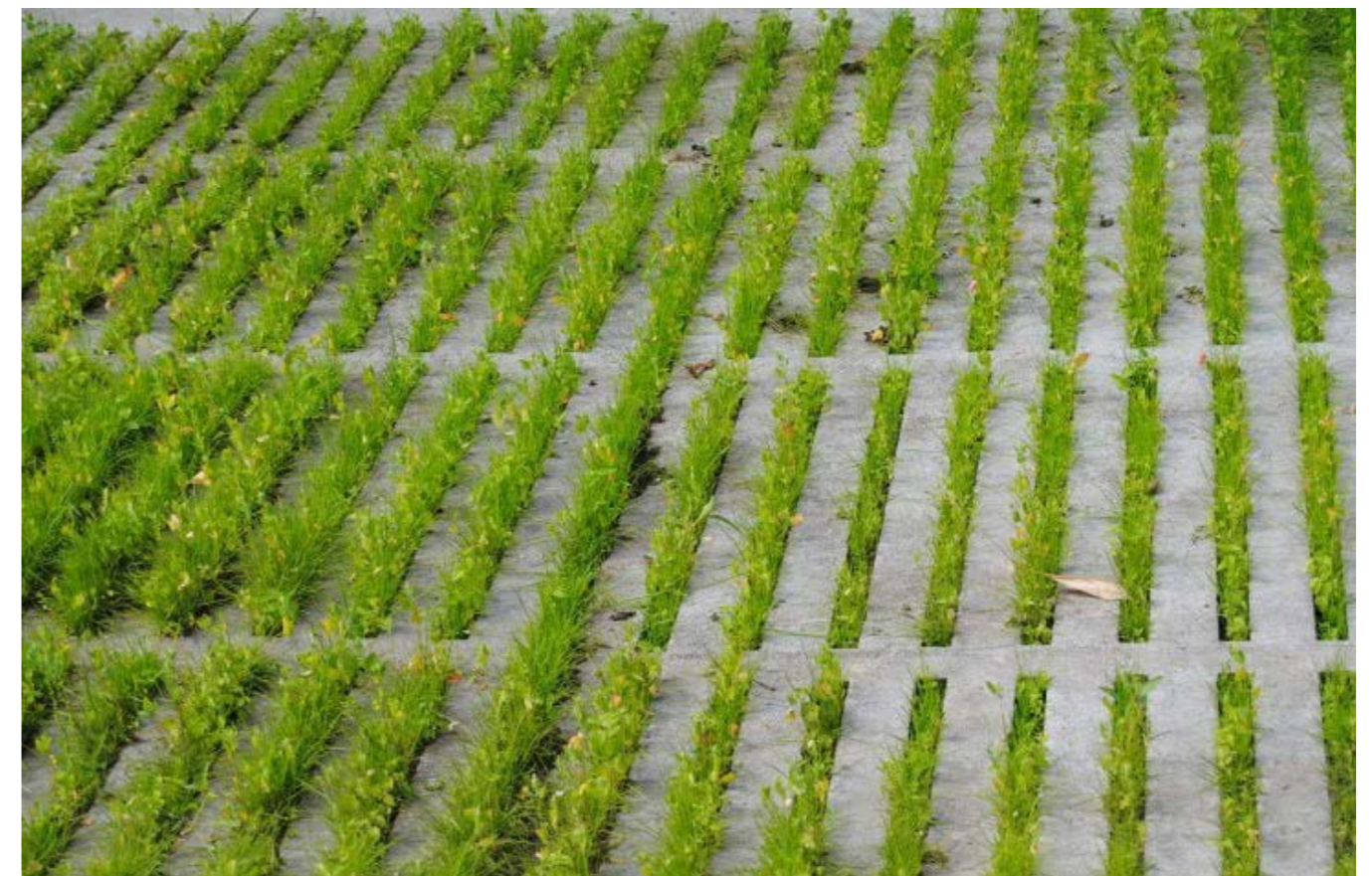
Dwarsparkeerplaatsen in groensleufplaten, beton
