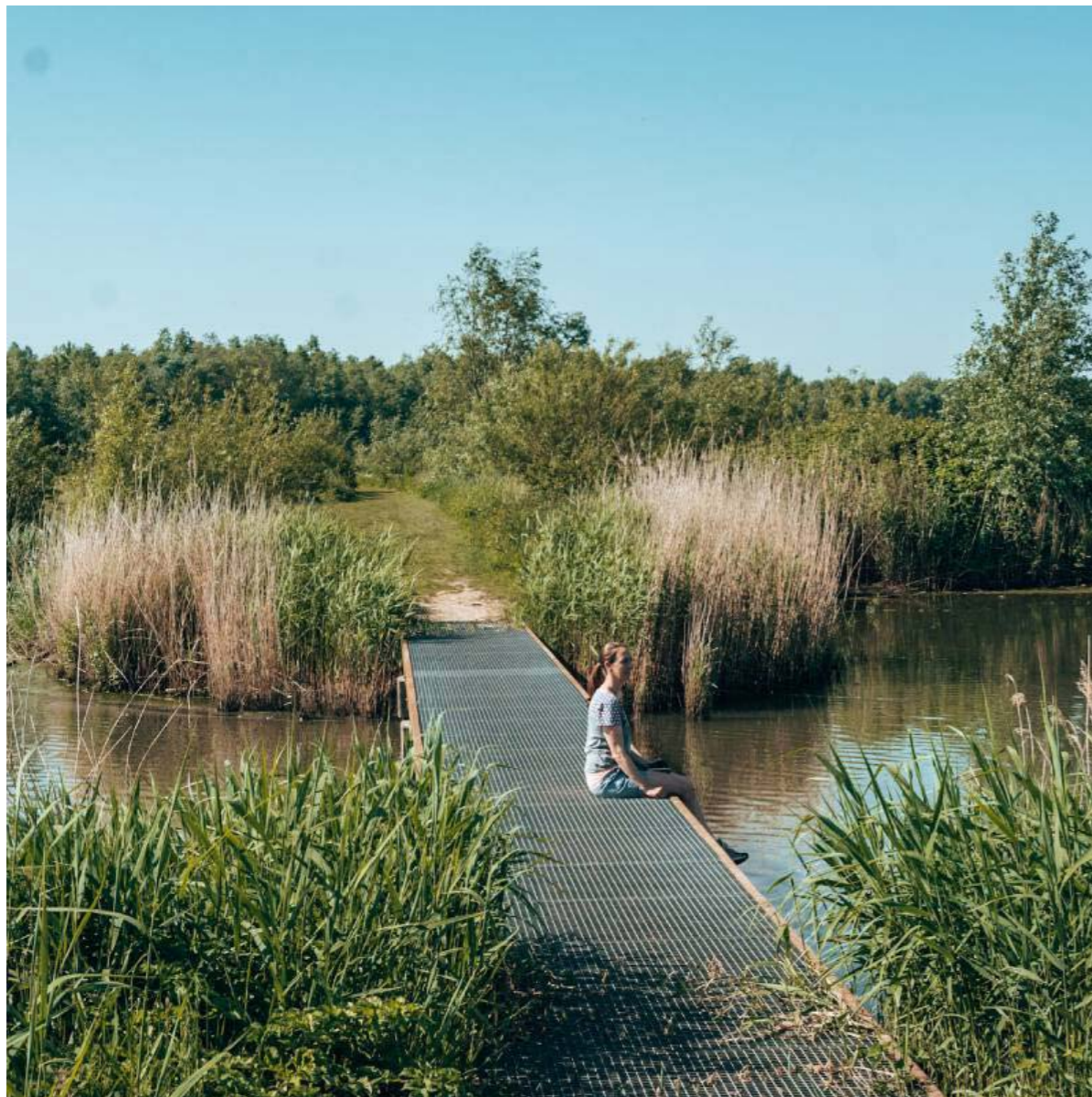
Vlonder zonder balustrade als wandelpad over de waterpartij.
