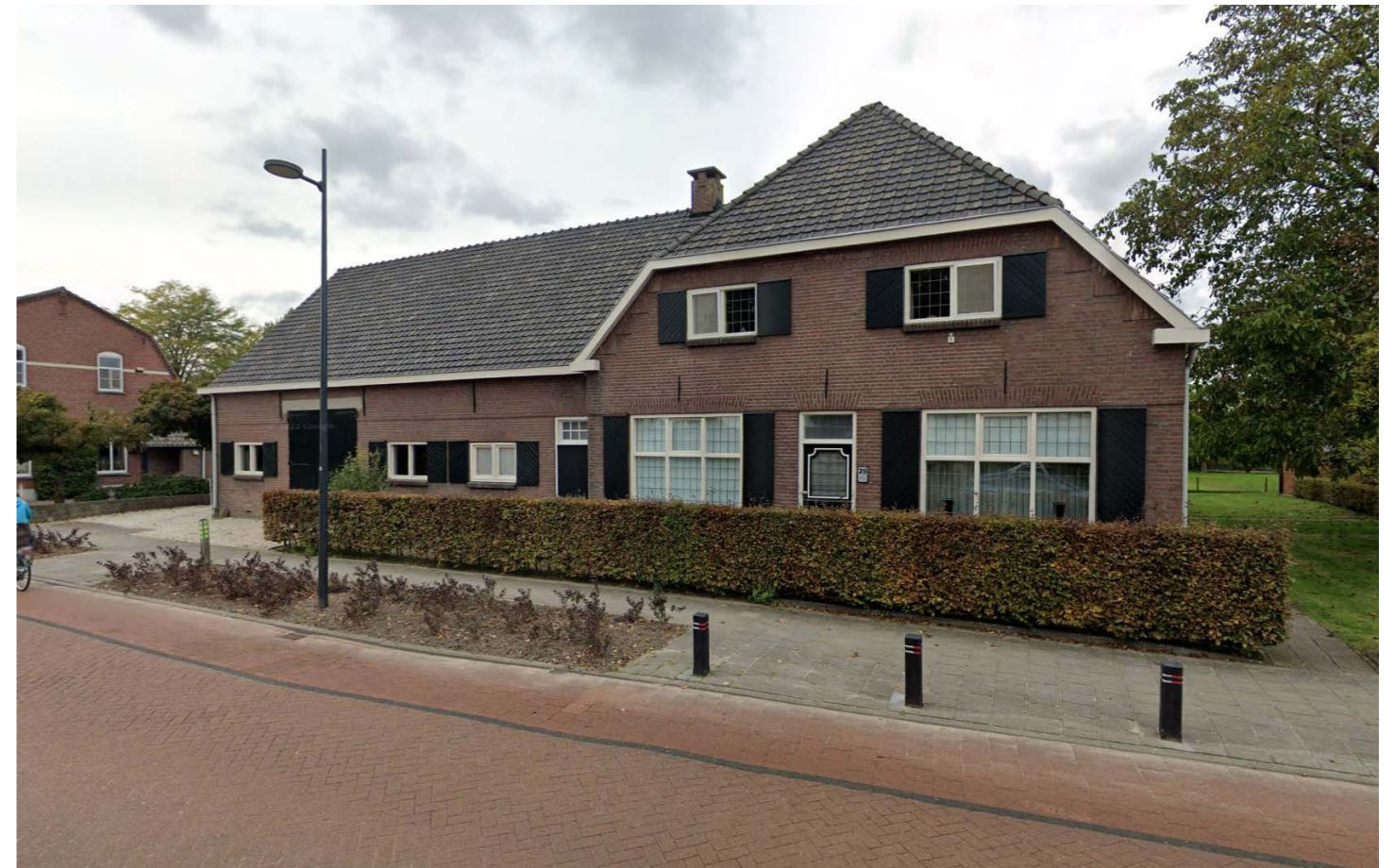
langgevelboerderij met ingetogen kleurenpalet
