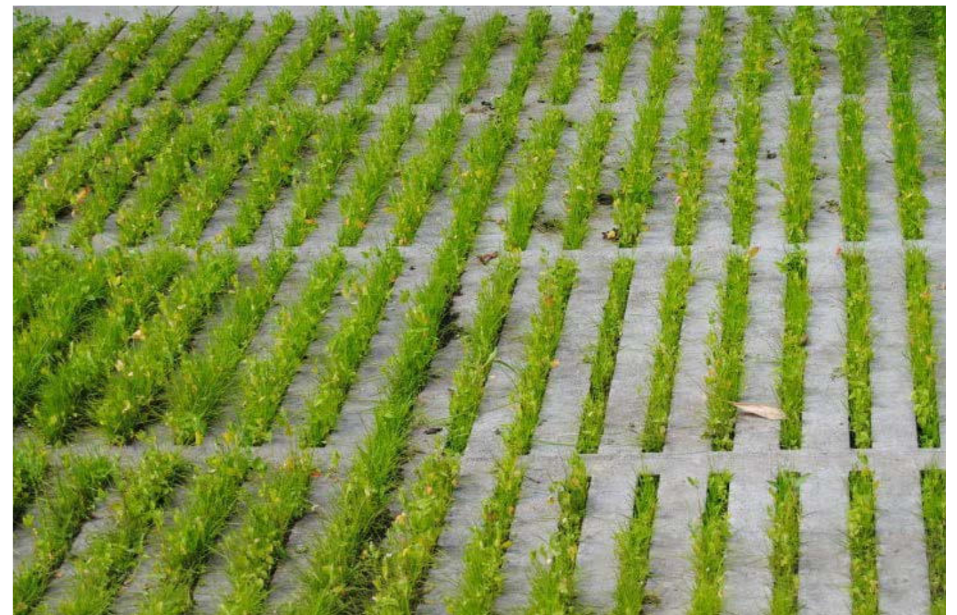
Dwarsparkeerplaatsen in groensleufplaten, beton
