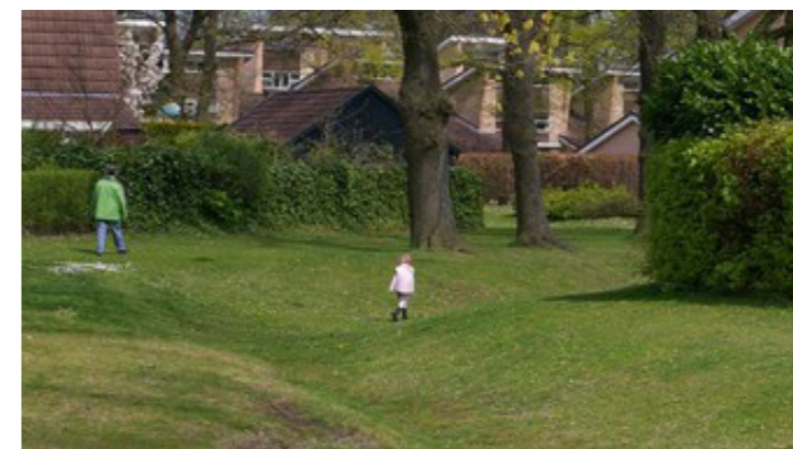
Wadi's als zichtbare waterberging (droge periode)
