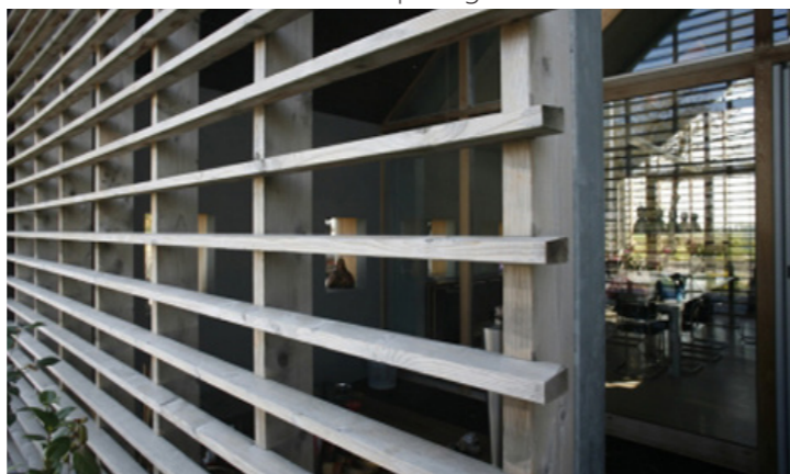
Houten lamellen als zonnewering
