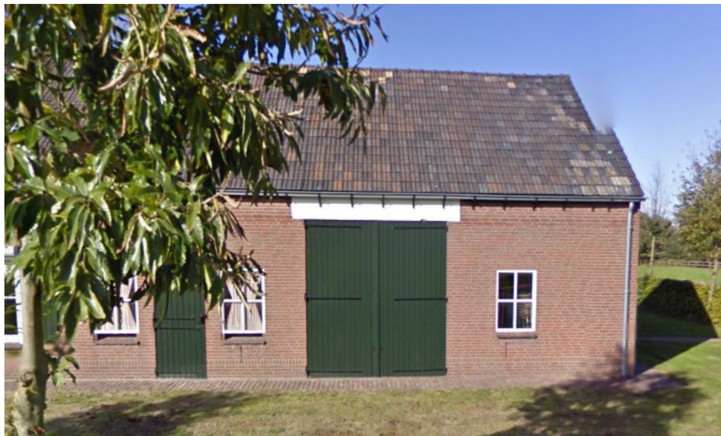
Bestaande boerderij aan het Hoogheke
