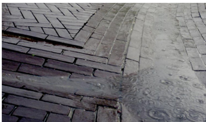
Zichtbare hemelwater afvoer
