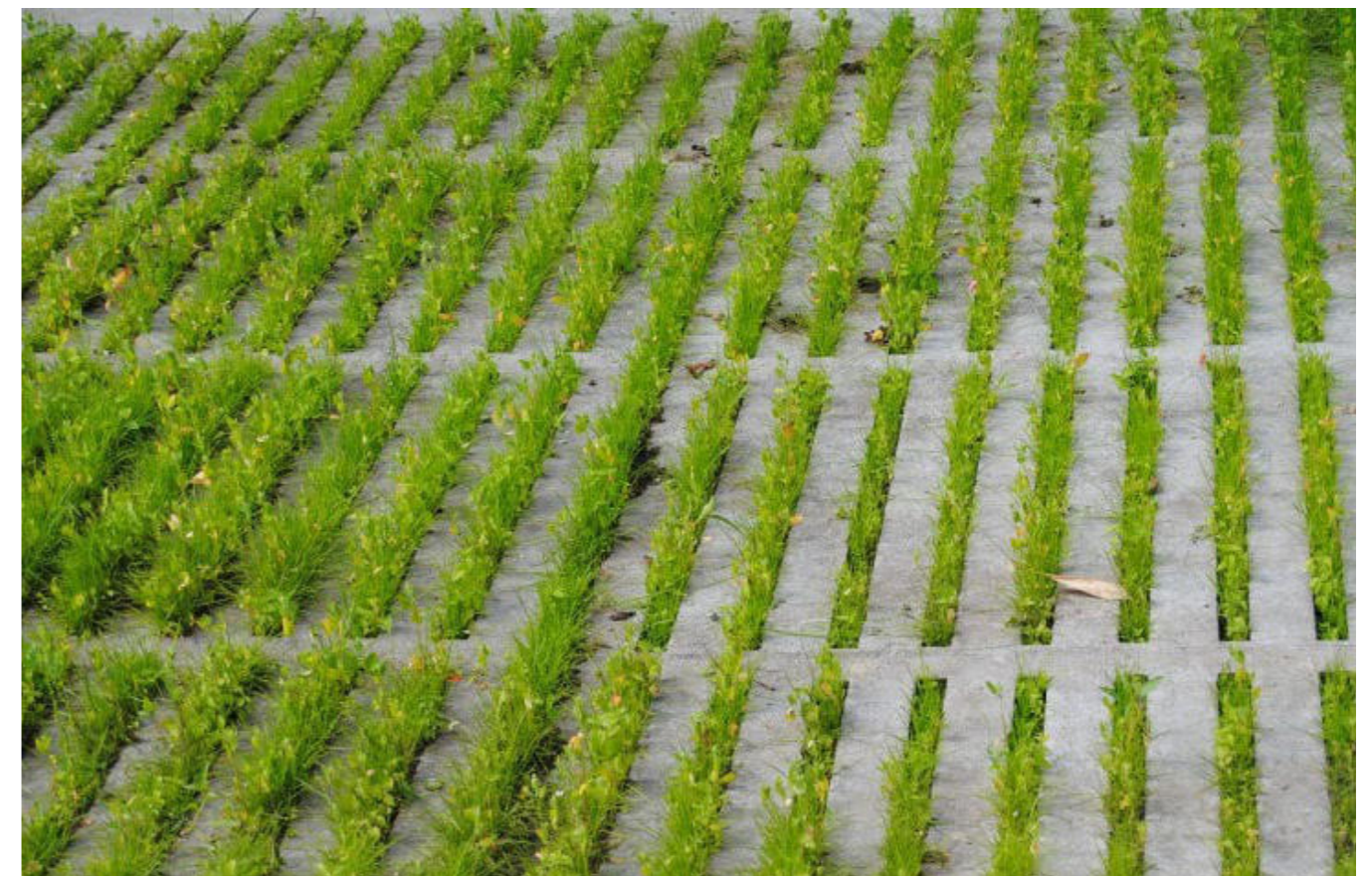
Dwarsparkeerplaatsen in groensleufplaten, beton.
