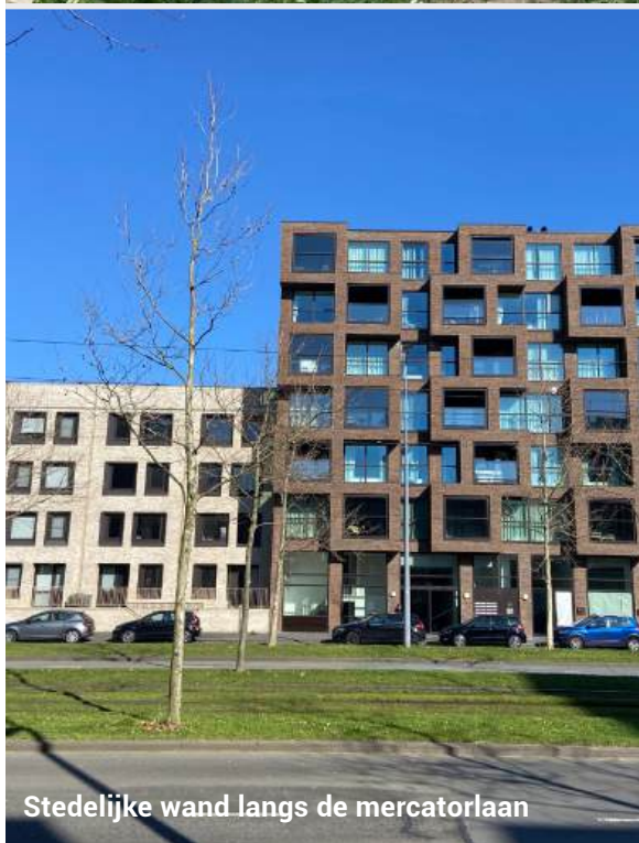
Binnenhoven: door toepassen van een dubbelhoog raster wordt de grote schaal van het gebouw visueel verkleind.
