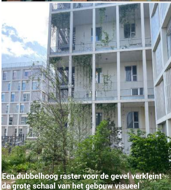
Plastiek in het metselwerk d.m.v. kaders terugliggend metselwerk; rust door gelijke steenkleur
