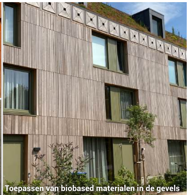
Toepassen van biobased materialen in de gevels
