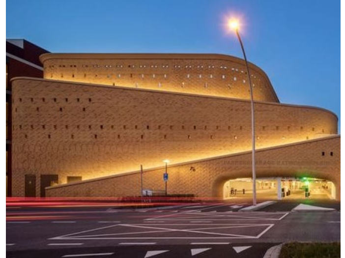
Figuur 47. Parkeergarage dag en nacht aantrekkelijk. Katwolderplein, Zwolle.
