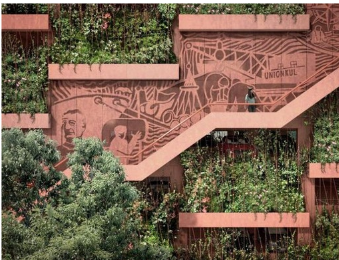
Figuur 46. Gevelvergroening en expressie van de gevel. Kopenhagen (DK), Park-n-Play
