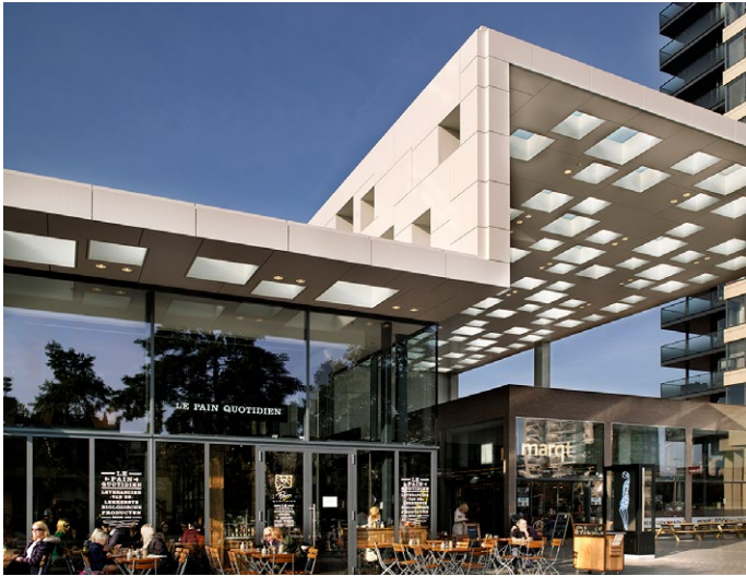
Figuur 90. Luifel als architectonisch element met verbijzondering van de entree. Amsterdam, Gelderlandplein
