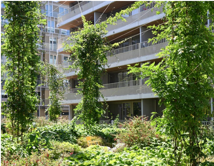
Figuur 36. Binnenhof als het groene hart van het gebouw Amsterdam, Overhoeks
