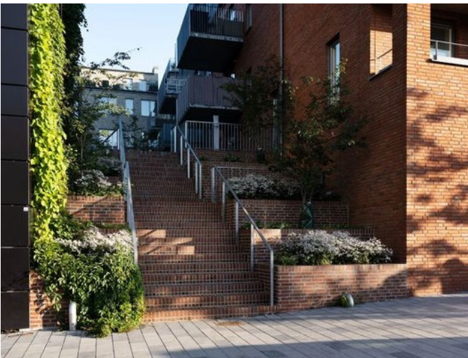
Figuur 12. Snedes in de plint ontworpen als onderdeel van het ensemble. Tyresö (SE), Norra Centrum
