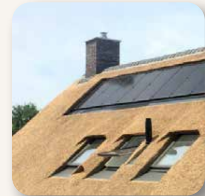
verwerking zonnepanelen op dak meegenomen in de gevel
