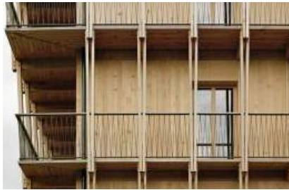
A. Gelamineerde houten draagconstructie
