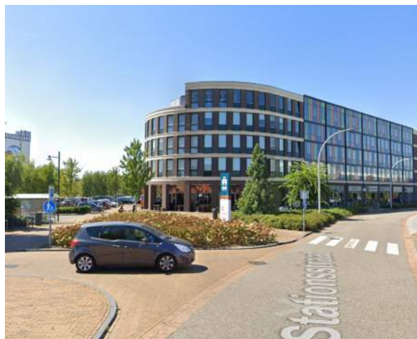
Stationsstraat ter hoogte van Iseldoks
