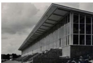
oude renbaantribune op Sportpark met grote slanke glasgevel en herkenbaar dak
