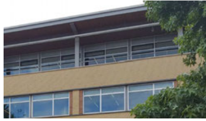
Gevelbeëindiging met duidelijke dakrand. Nike kantoor, Hilversum.
