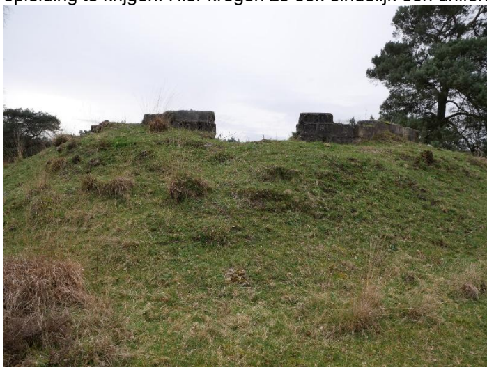
De fundamenten van de Freya radarpost op een heuvel. Onderdeel van het BAZI kamp van de Duitsers (foto J. Timmers).
