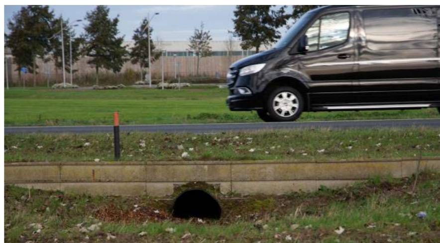
Figuur 3.17 Ecologische verbinding onder de rijbaan. Culemborg.
