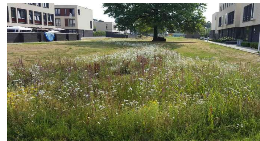
Figuur 3.19 Wadi op bedrijventerrein. Bron: Rioned.
