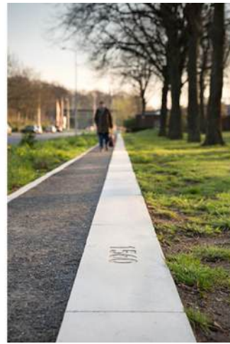
Stevige opsluitband met halfverharding
