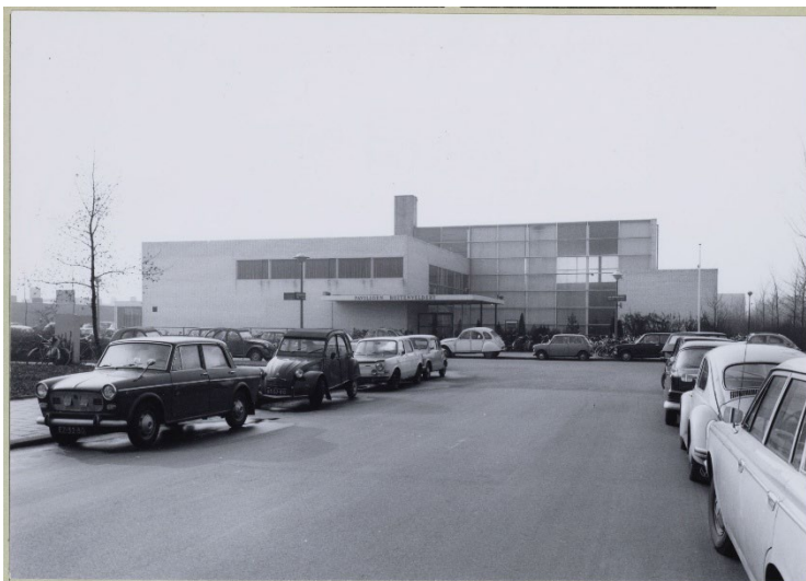
De voormalige kerk van de Vrije Gemeente, ontworpen door bureau Rietveld, Van Dillen en Van Tricht (1972). Bron: SAA / Archief van de Dienst Ruimtelijke Ordening: foto's afdeling B, B00000009891.
