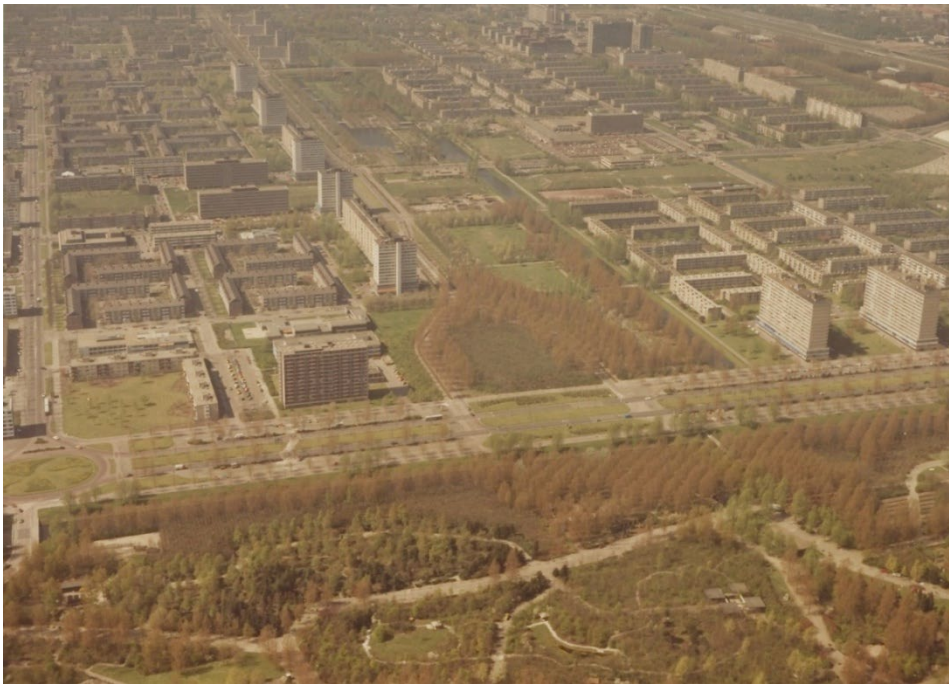
Luchtopname in westelijke richting (1981). Op de voorgrond het Amstelpark en de Europaboulevard. In het midden sluit het Gijsbrecht van Aemstelpark daarop aan. Bron: SAA, Archief van de Dienst Ruimtelijke Ordening: foto's afdeling B, B00000035819.
