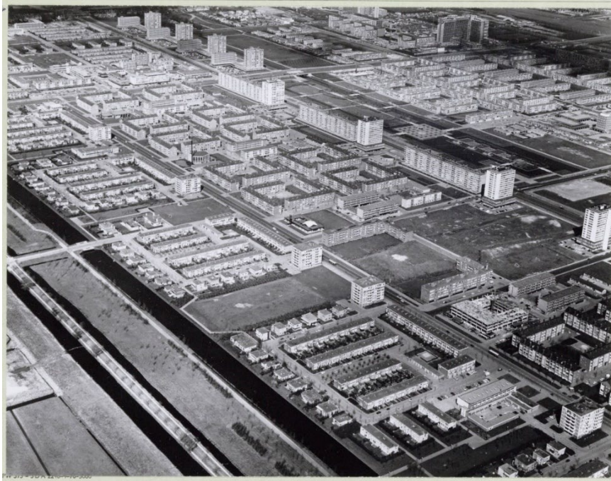
Luchtfoto vanaf de zuidoostelijk hoek van de wijk gezien in noordwestelijke richting (1970). Linksonder diagonaal de Kalfjeslaan. In het midden is het zandlichaam zichtbaar voor de geplande Rijksweg A3. De geleidelijke opbouw van laag- naar middel- en hoogbouw is goed zichtbaar. Bron: SAA, Dienst der Publieke Werken; Afdeling Stadsontwikkeling, 010009015669.
