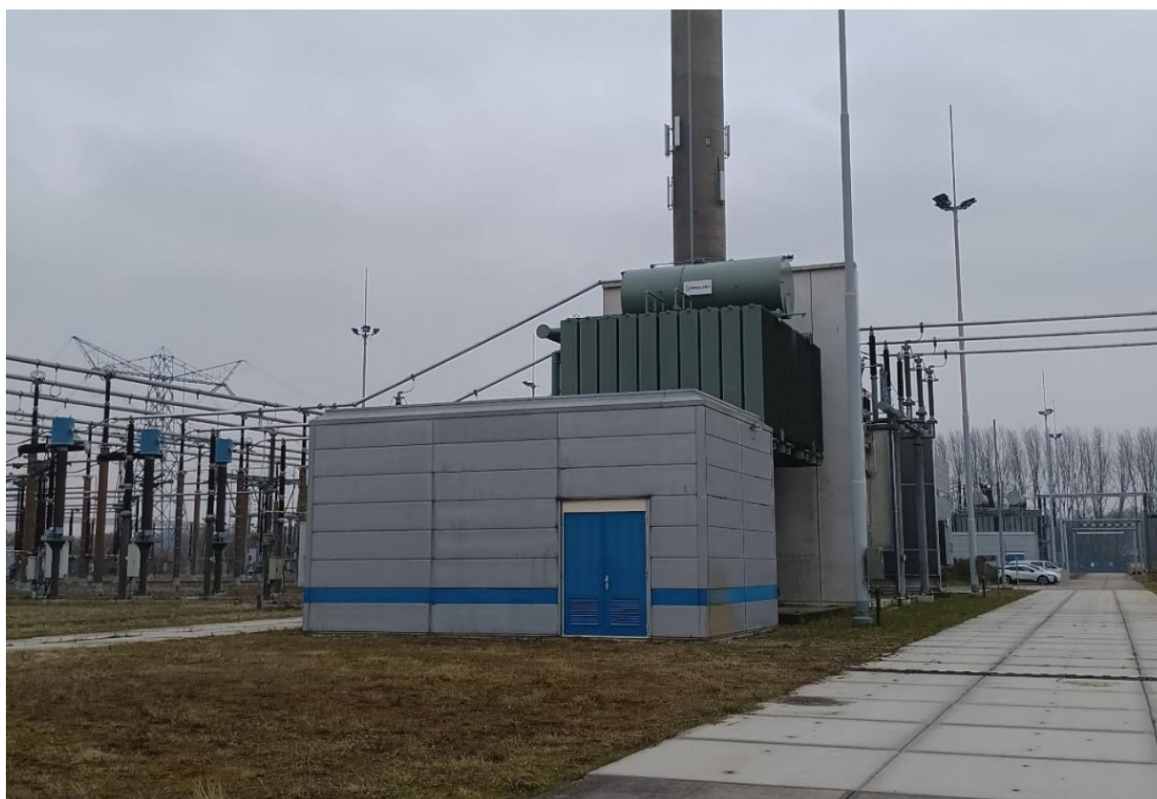
Figuur 3.4: Op de voorgrond het te slopen brandhuisje. De reeds aanwezige lichtmasten op de achtergrond.
