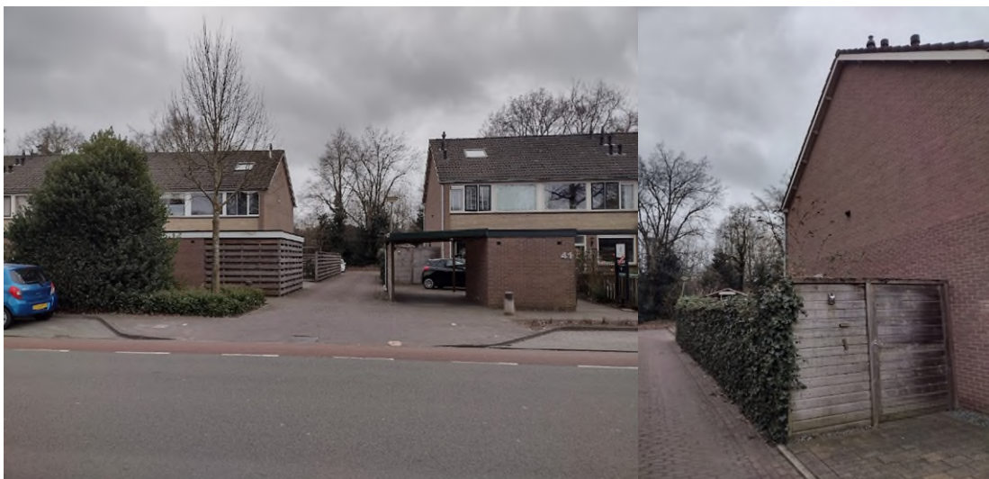
Figuur 2.5 Overzichtsfoto van de woningen aan de Nijverheidsweg (links) en een foto van een van de kopgevels (rechts). De situatie van bijgebouwtjes en groen rondom de woningen verschilt sterk van woning tot woning
