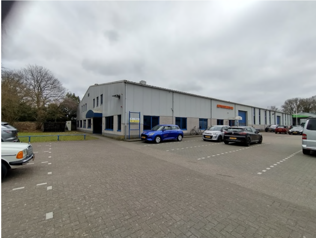
Figuur 2.4 Overzichtsfoto van het pand aan de Nijverheidsweg 101 met onder andere de Kringloop en een autoschadeherstelbedrijf
