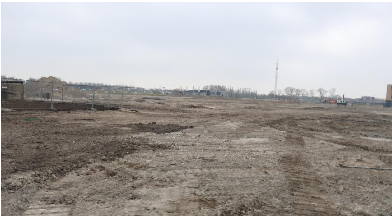
Figuur 4.2 Binnen het plangebied zouden grondbroedende vogels kunnen gaan broeden.
