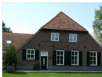
Figuur 2.8 Noordelijke gevel van de boerderij.
