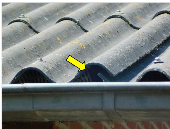
Figuur 5.1 Dakgoot varkensstallen met open vogelschroot.
