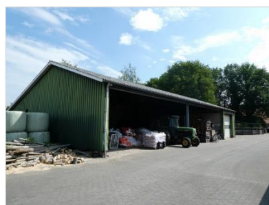
Figuur 2.5 Noordwestelijke kapschuur met paardenstal.
