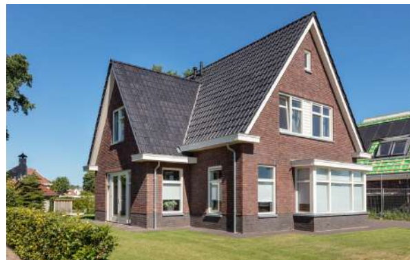
jaren '30 woning met een ondergeschikte langskap
