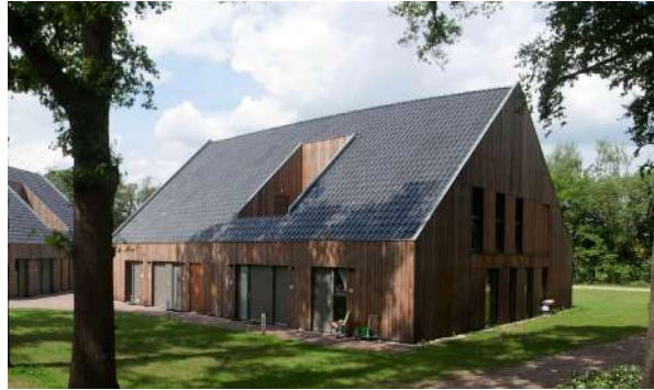
klassieke vorm van een huis met veel licht door een hap uit het dak
