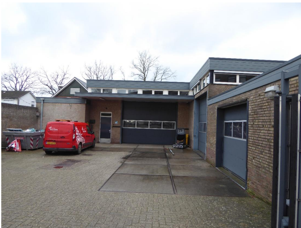
Te slopen laagbouw (deel A) van oud postkantoor
