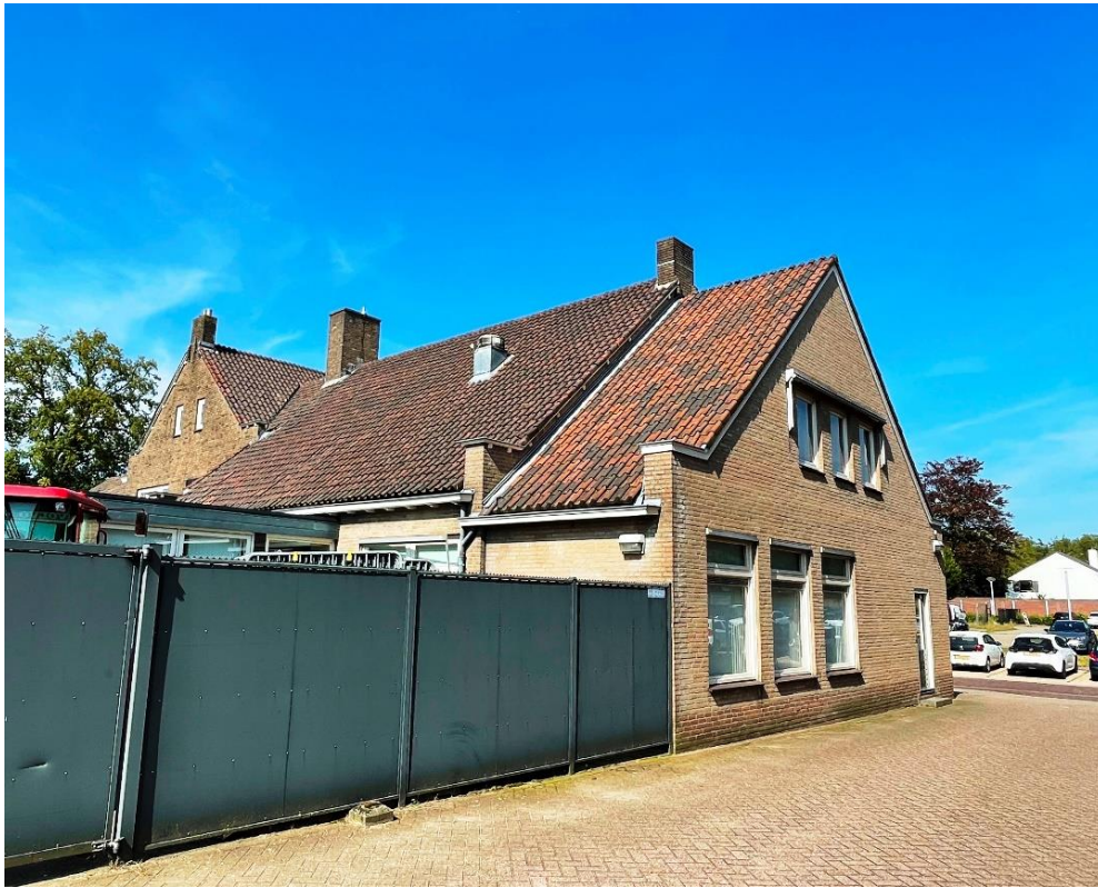
Linker zijgevel en achtergevel kantoor.
