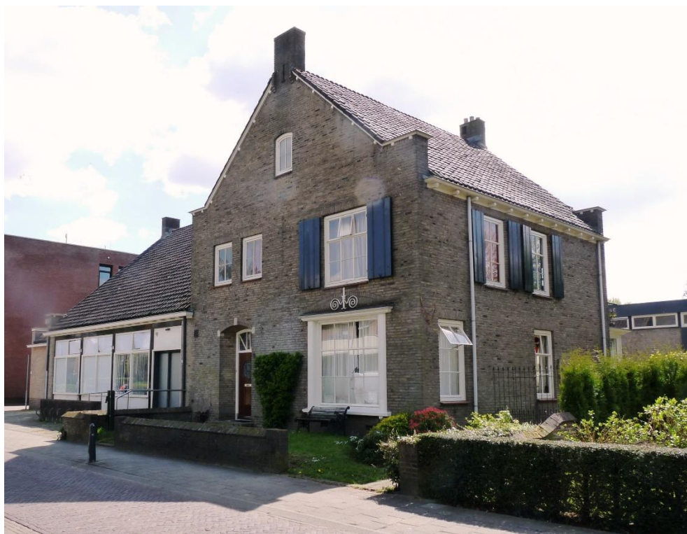
Voorgevel en rechter zijgevel.
