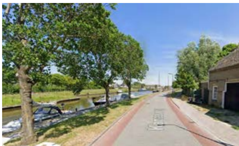
Huidig straatprofiel Kanaalweg
