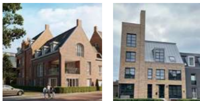
Verwijzing naar de stins (In grondgebonden woningen)
