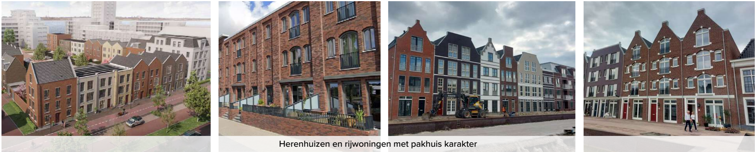
Herenhuizen en rijwoningen met pakhuis karakter
