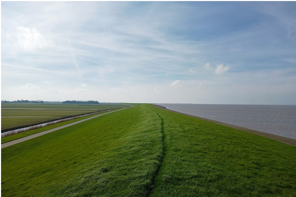
Afbeelding 2.7 Dijk in deeltraject Polder (richting het westen)
