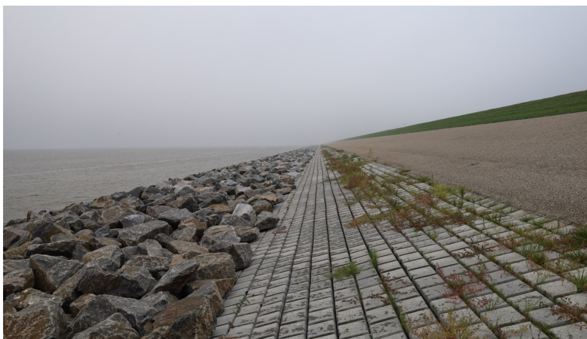
Afbeelding 5.7 Impressie teenconstructie van breksteen (foto dijkversterking Lauwersmeerdijk-Vierhuizenrat)
