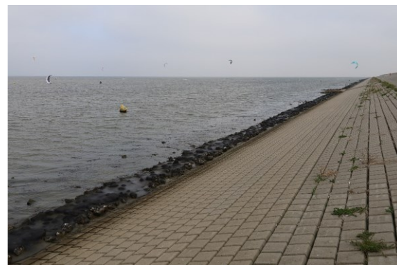
Type bekleding: vol en zat gepenetreerde breuksteen (onder in het profiel op de foto). Bij 'vol en zat' penetratie wordt alle holle ruimte in de laag breuksteen gevuld met gietasfalt.
