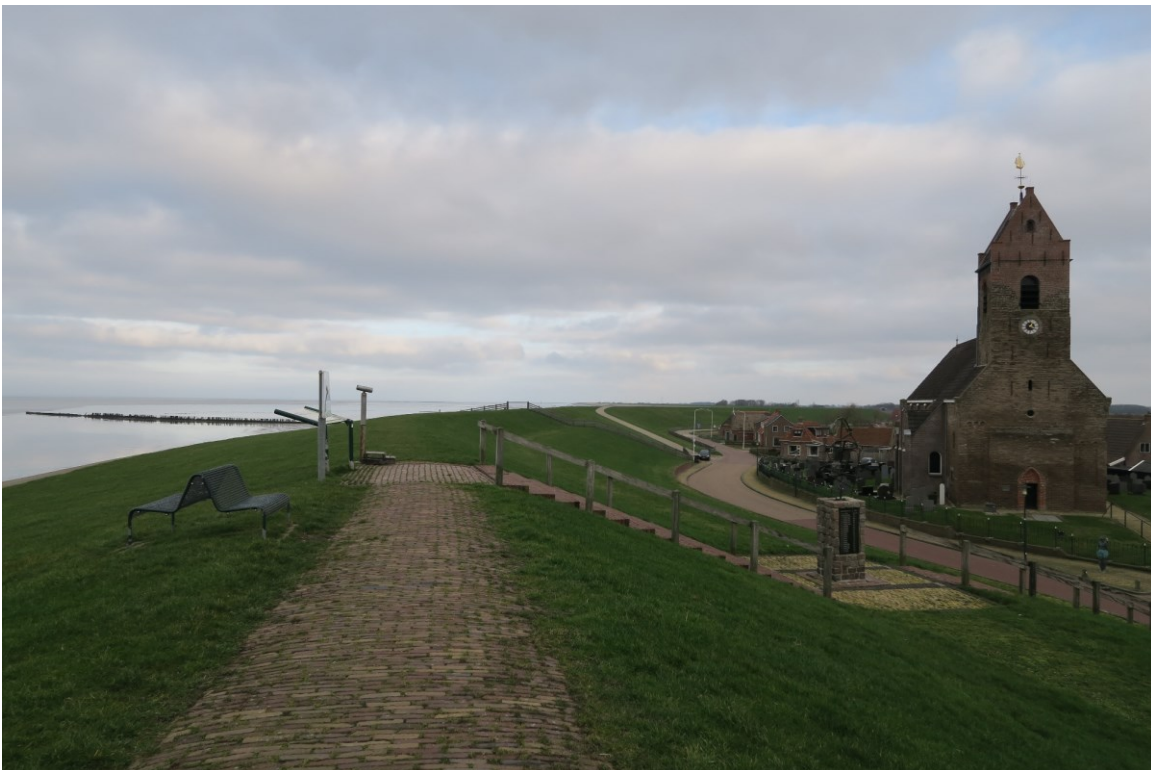
Afbeelding 2.10 Dijk in deeltraject Wierum dorp (richting het oosten)
