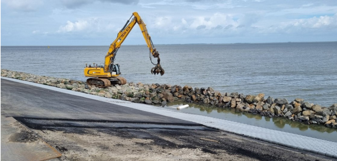
Afbeelding 6.4 Dijkverbetering Lauwersmeerdijk waar een HGM over de breuksteen rijdt en dit afwerkt
