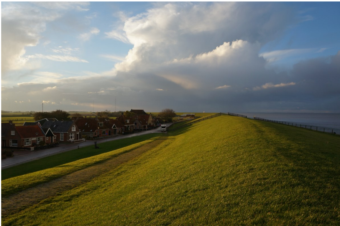
Afbeelding 2.11 Dijk in deeltraject Peazens-Moddergat (richting het noorden)
