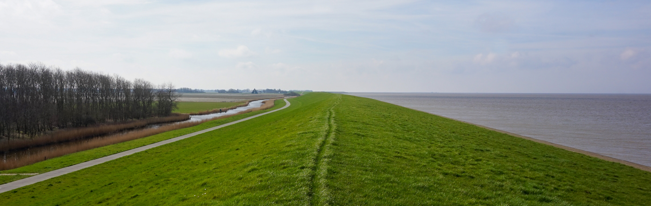
Afbeelding 7 Het profiel is binnendijs steiler dan buitendijk. De kruin is smal. Over lange lengte kronkelt de dijk vaak licht.
