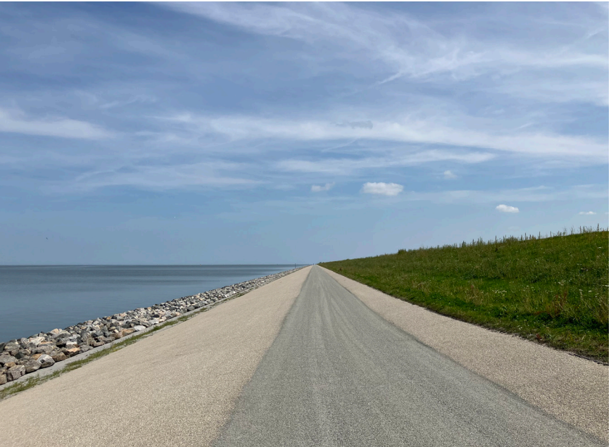
Afbeelding 17 De buitendijkse delen die geschikt zijn om te fietsen en onderdeel zijn van de OPLIW-route, zullen subtiel worden gemarkeerd met een grijze en bruine splitlaag, zoals die ook op de Lauwersmeerdijk (foto boven) is aangelegd.
