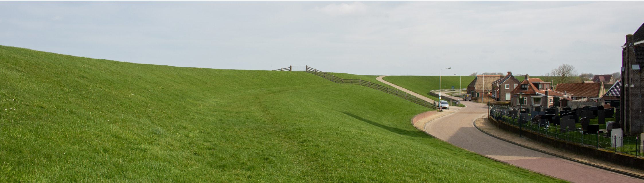
Afbeelding 8 Bij Wierum is het binnentalud getrapt. Dit vlakke deel is de voormalige kruin, voordat de dijk in de jaren '70 werd opgehoogd.
