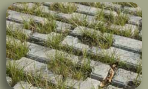
Open beton klinker Halverharding parkeren
