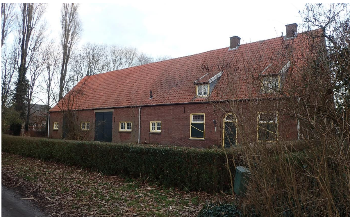
Figuur 30. Deelse Kampen 11 in de huidige situatie, met de luiken gesloten (foto: RAAP, 6 februari 2023).
