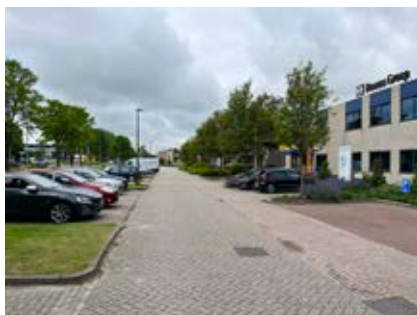
Bestaande bedrijfsbebouwing langs de Zuiderweg
