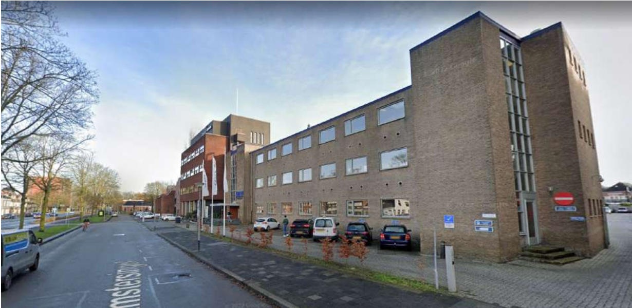
Figuur 3-8 Certe-gebouw, vanaf het Damsterdiep
