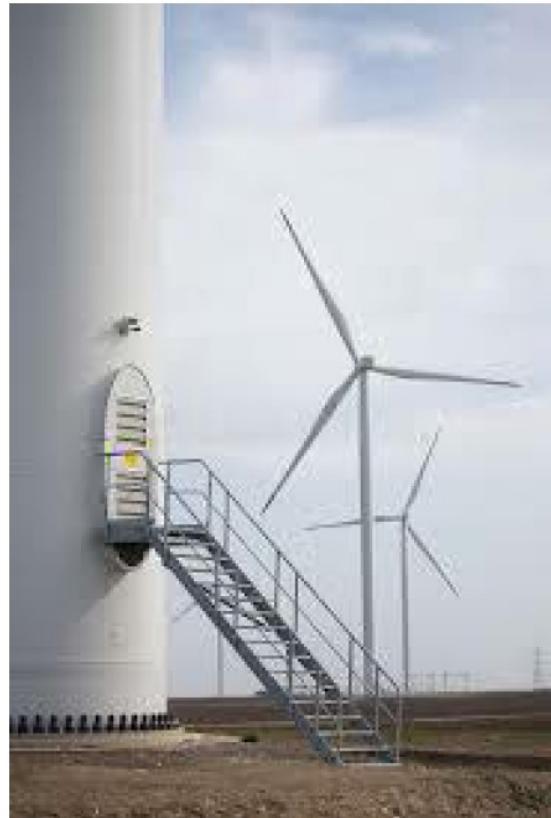
Afbeelding 3.2 Impressie principe trappen en deuren, windturbines (bron: Google.com)
