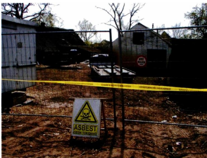
Figuur 17: Afscherming van een asbestverdachte locatie
