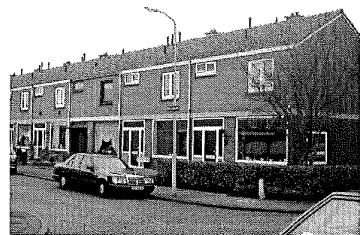
Grote ramen in de begane grondgevel.
