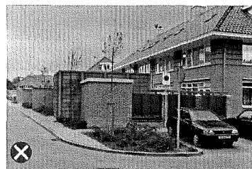
Niet passend door omvang, materiaal- en kleurgebruik.
