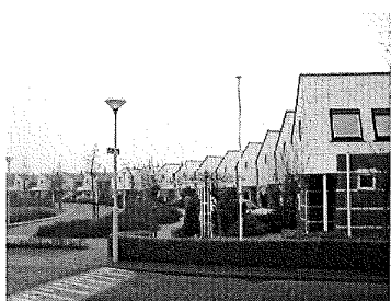
Geschakelde seriematige woningen veroorzaken sterke wandwerking.
