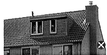
Niet passend door afwijkend materiaal- en kleurgebruik.
