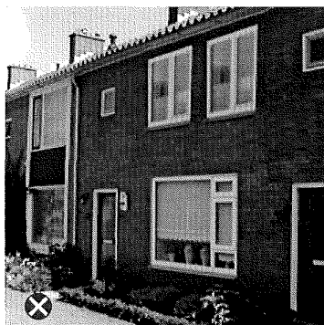
Niet passend door afwijkende indeling.
