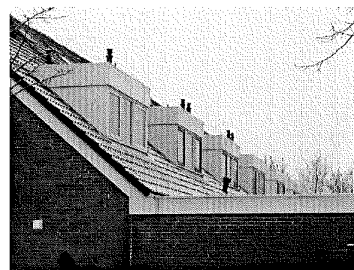
Toevoegingen aan één bouwblok identiek vormgegeven.
