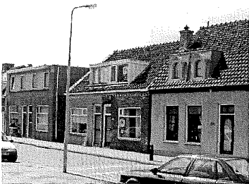
Kleinschalige bebouwing met een verticale gevelindeling.
