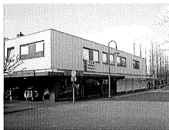
Visuele scheiding van bouwlagen is niet wenselijk.
