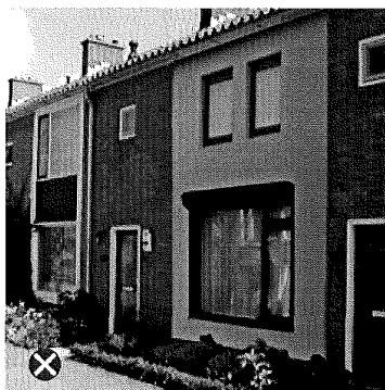
Niet passend door afwijkend materiaal- en kleurgebruik.
