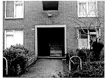
Prefab elementen in het gevelbeeld.
