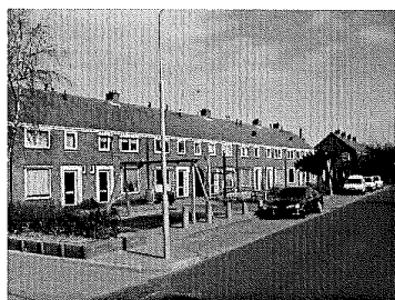
Geprefabriceerde entreepartijen in Kerkbeek.
