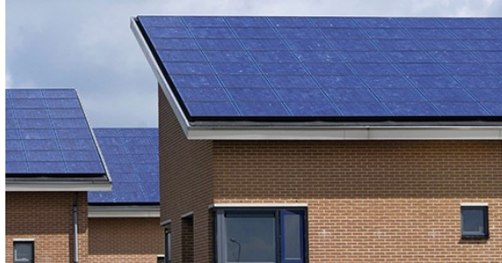
Voorbeeld zonnepanelen geïntegreerd in dakconstructie (BIPV)
