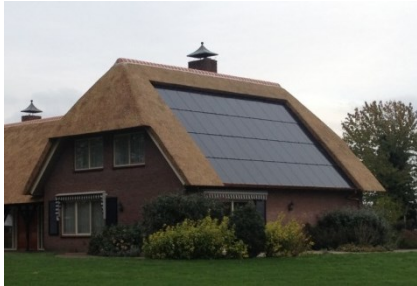
Voorbeeld PV-panelen geïntegreerd in dakconstructie (BIPV)
