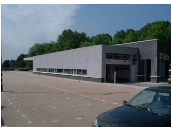
Benzinestation in de stationsomgeving staat los in de ruimte.
