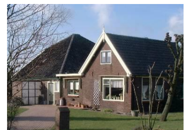
Dergelijke detaillering en kleur- en materiaalgebruik passen goed in het landelijke gebied.
