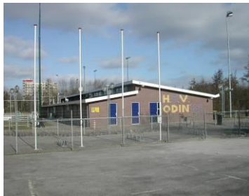
Bebouwing met eenvoudige massa en flauw hellend dak.
