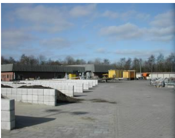
Gemeentelijk opslagterrein met sterk teruggelegen bebouwing.
