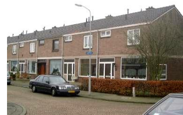
Grote ramen in de begane grondgevel.
