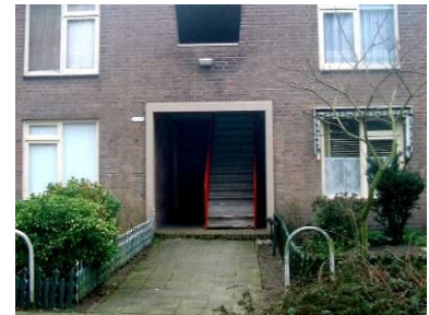
Prefab elementen in het gevelbeeld.
