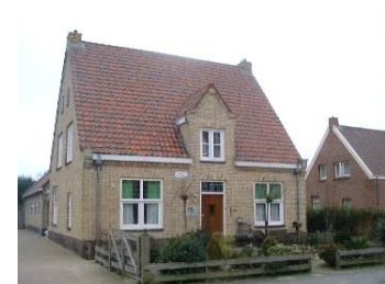
Oorspronkelijke gevel gerestaureerd. Veel details zijn behouden.
