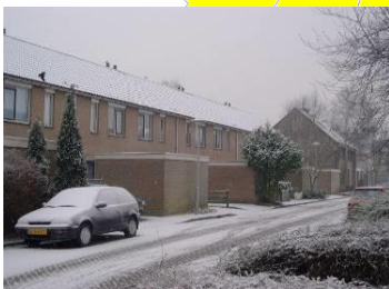
Gesloten beeld door bijgebouwen aan de straat.
