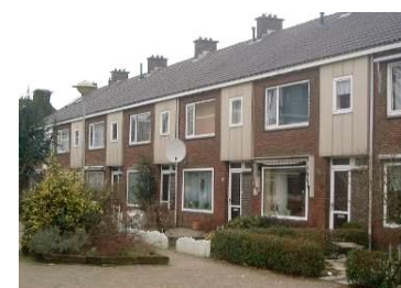
Plaatmateriaal op de gevels versterkt de ritmiek.
