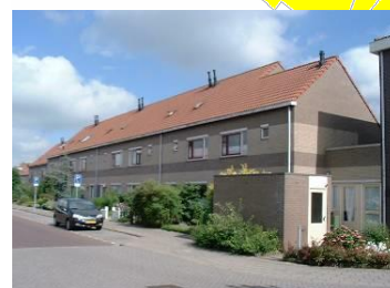
Twee kleuren steen per bouwblok.
