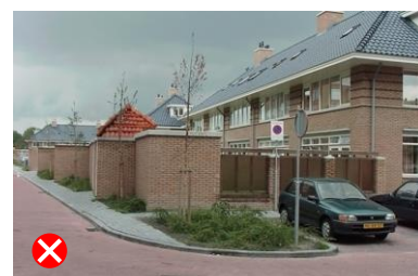
Niet passend door afwijkende kapvorm.
