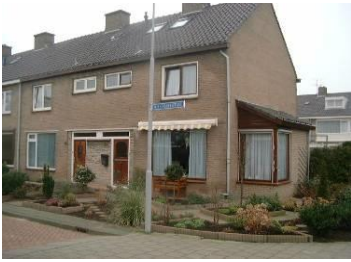
Entree wordt geaccentueerd door afwijkend metselwerk.
