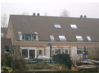
Achterzijdes op een zichtlocatie vragen meer aandacht.
