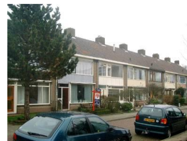
Glazen gevels op een gemetselde plint.
