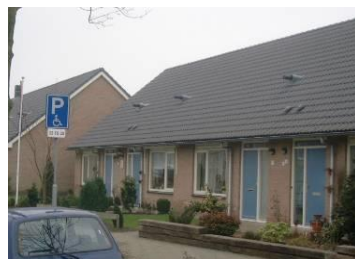
Woningen van één bouwlaag met een zwaar, gesloten dakvlak aan de Zevenhoeven.
