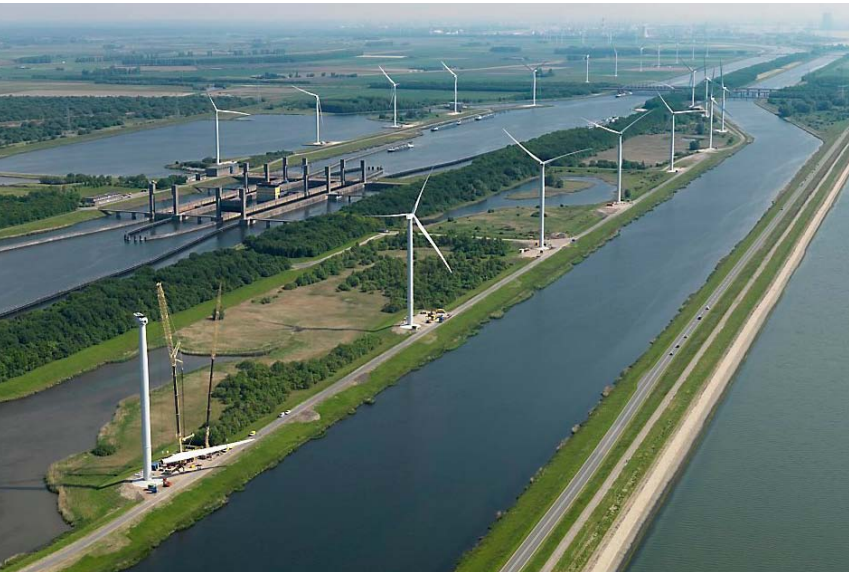
Windturbines Kreekraksluizen markeren kanaal en sluiscomplex
