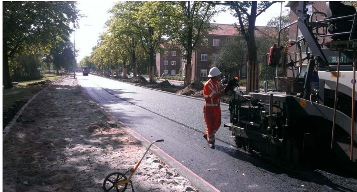
Figuur 2 Vervanging fundering en asfalt Vondelstraat
