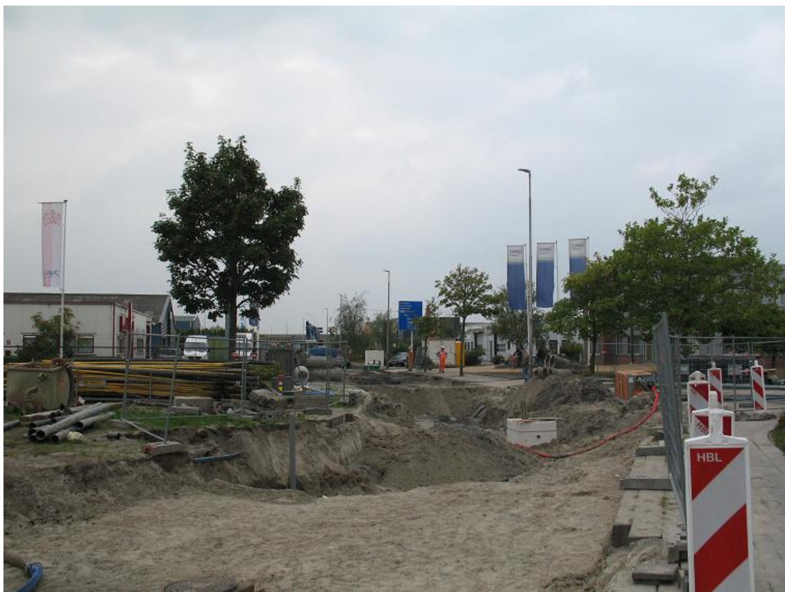
Afbeelding 18: aanleg/vervanging riolering geeft soms kortdurende overlast (Uranusweg)
