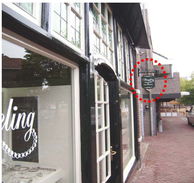
Smeedijzeren uithangbord haaks op de gevel
