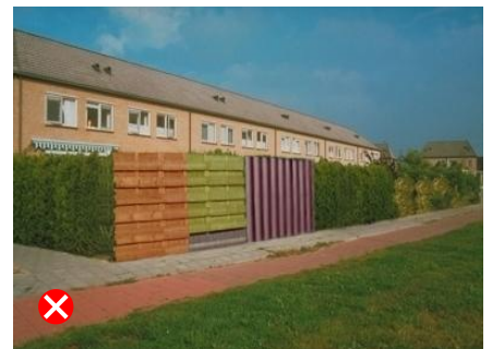
niet passend door afwijkend materiaal- en kleurgebruik
