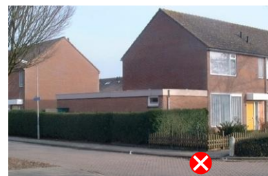
niet passend door plaatsing in rooilijn
