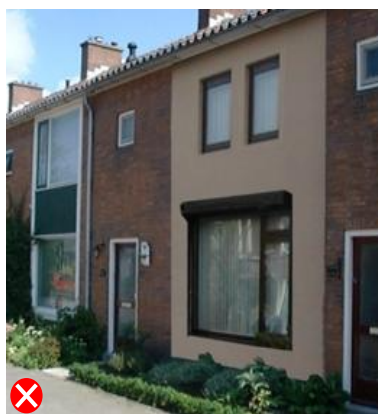
niet passend door afwijkend materiaal en kleur gebruik
