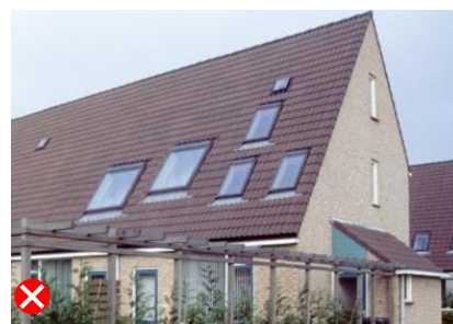
niet passend door onregelmatige rangschikking (wel vergunningvrij)
