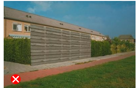
niet passend door afwijkende hoogte
