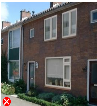
niet passend door afwijkende indeling
