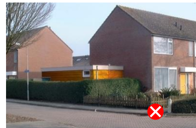
niet passend door afwijkend materiaal en kleurgebruik
