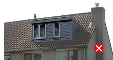
niet passend door afwijkend materiaal- en kleurgebruik
