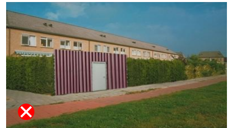
niet passend door gebruik damwandprofiel
