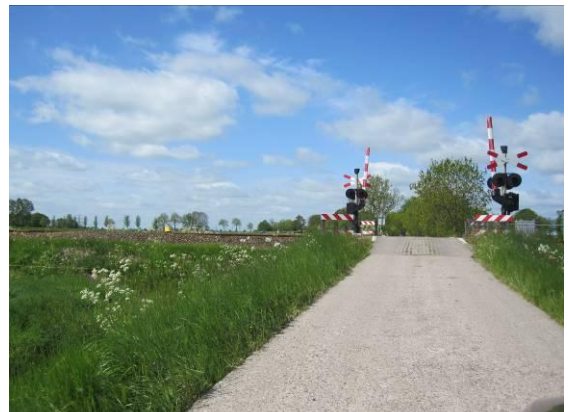
zwak - belemmering zicht door spoordijk
