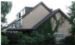
Overkapping aan de zijgevel die plat afgedekt is.
