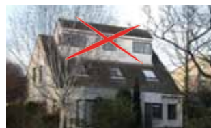
Dakopbouw op een schuin dakvlak die boven de dakenok van het hoofdgebouw komt.
