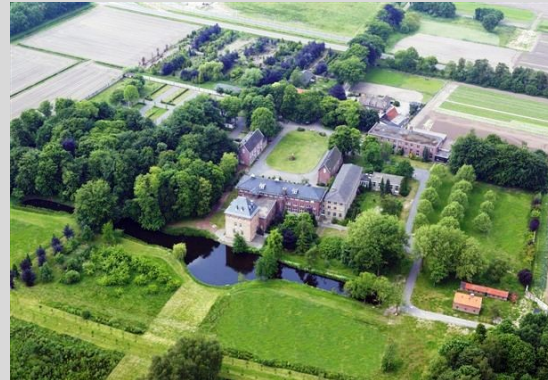
Luchtfoto Abdij Mariënkroon – voormalig Kasteel Onsenoort
