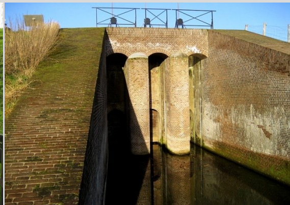
Inundatiesluis bij Fort Hedikhuizen (foto: Heemkunde van de Oostelijke Langstraat)
