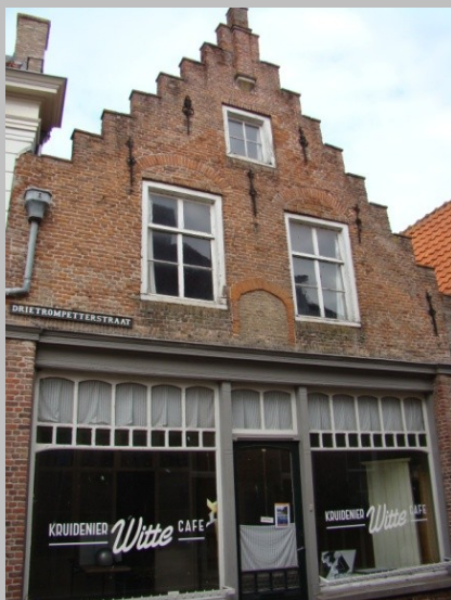
In 2009 werd voor de verbouwplannen aan het pand Drietrompetterstraat 16-18 te Heusden een bouwhistorisch onderzoek verricht (foto: Rijksdienst voor het Cultureel Erfgoed)
