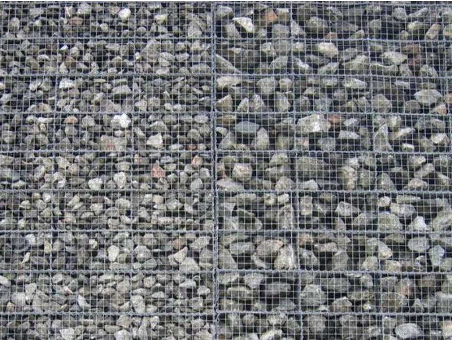
Schanskorven (onderverdeling in vakken slechts ter illustratie)
