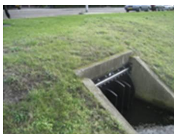
Riooloverstort riolering Dijkpolder
