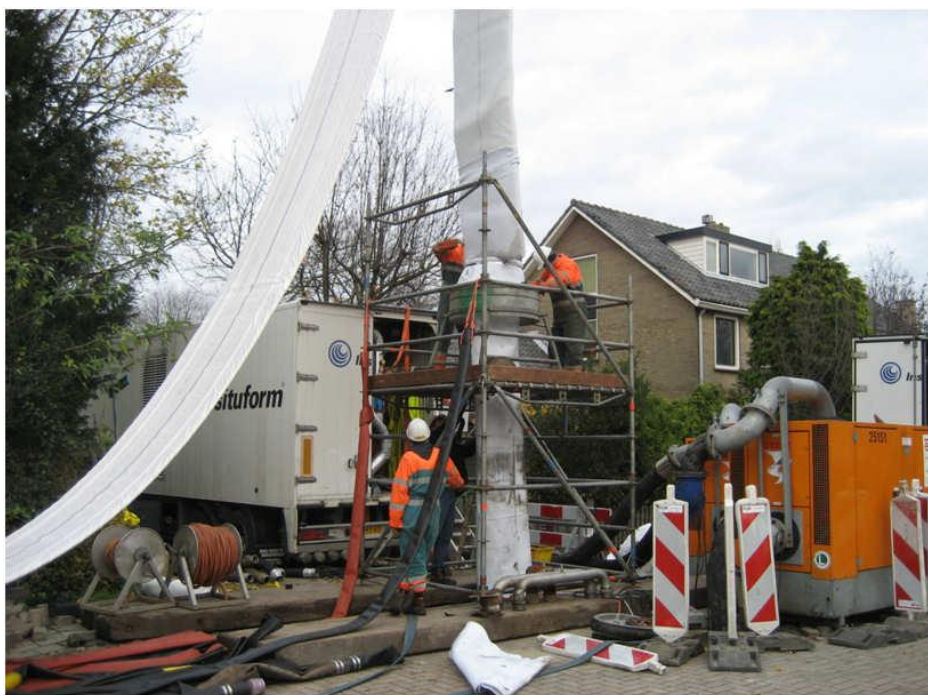
Figuur 2.7: Aanbrengen kous in riolering Molenweide
