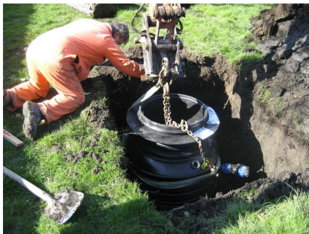
Figuur 2.4 Plaatsen pompput drukriolering
