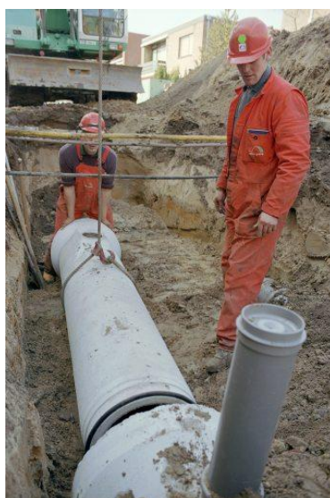
Figuur 2.8: Riolvervanging
