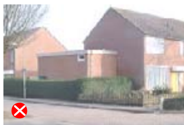
zijaanbouw te hoog
