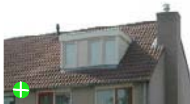
evenwichtig van plaatsing, grootte en vormgeving. Zijwangen bij voorkeur donker of kleur dakvlak.
