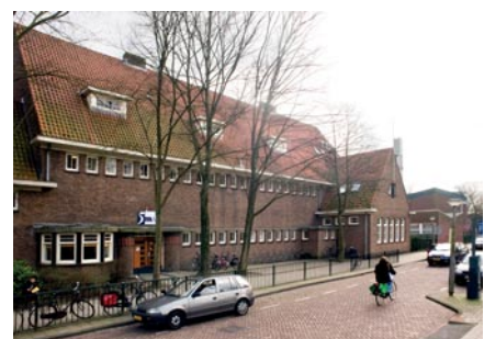
5e Montessorischool Betondorp
