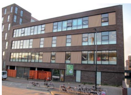
Kantoorpand Johan Huijsenstraat
