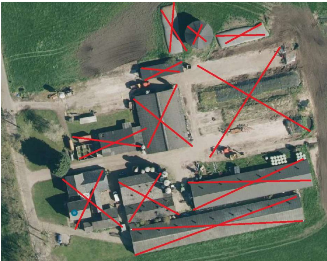
Afbeelding 6: Te slopen bebouwing
