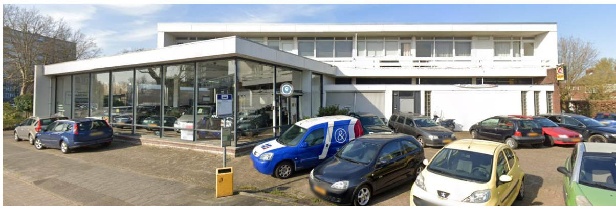
Figuur 2 Te slopen bebouwing
